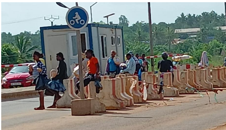
Photo 1 : Poste de péage de Sanguéra
