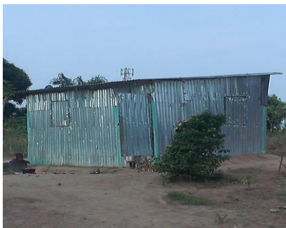
Photo 6. Maison en tôles dans la Zone 4.
