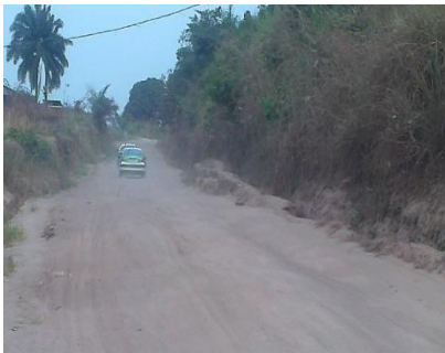
Photo 1. Etat d'un tronçon de l'avenue Jean-Claude GANGA, 1 ère voie d'accès à Mbouono, non bitumée et entretenue par les populations
