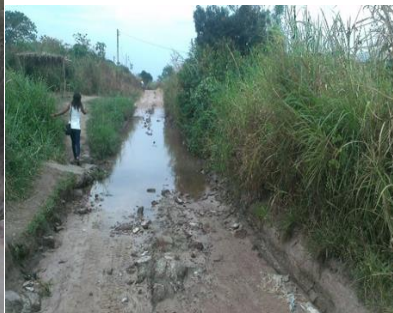
Photo 2. Etat de l'avenue NKOUTOU pendant la saison des pluies
