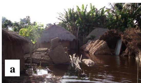
Inondation d'un village causant l'effondrement de certaines habitations
