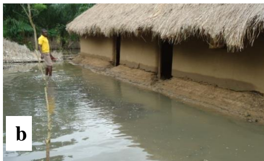
Case montrant le niveau atteint par l'eau lors des fortes inondations
